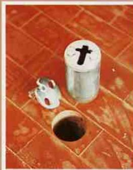
Bodenankertöpfe in verschiedenen Längen und Durchmesser lassen sich durch entsprechende Präzisionsbohrungen problemlos installieren.
